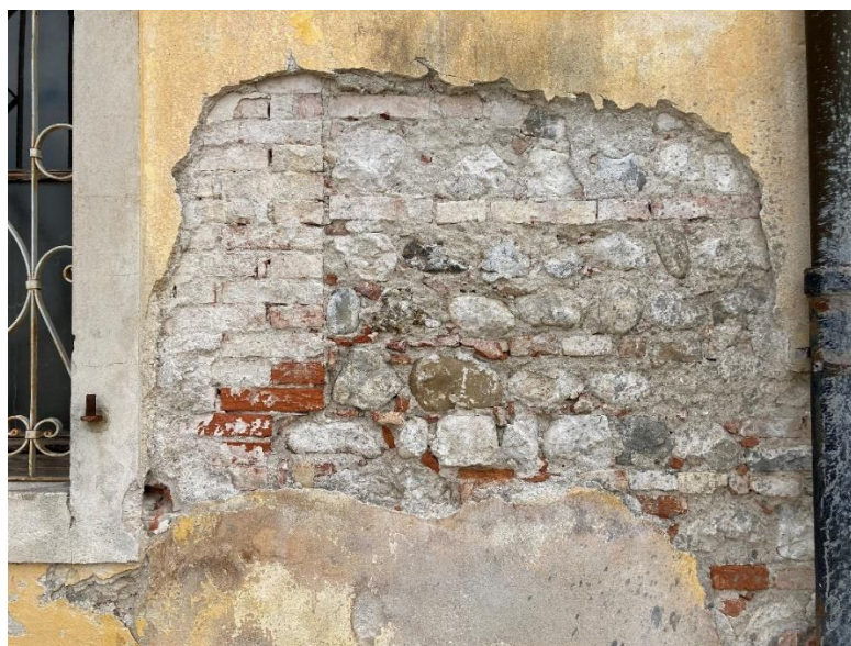
Figura 3: Grado di commistione della tessitura muraria
